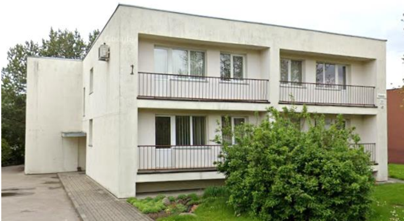
2 pav. Esama pastato būklė
